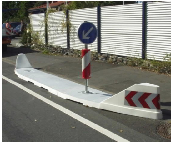
Abb. 102: Recyclingelement zur Verkehrsberuhigung, Foto: Fa. Lüft
