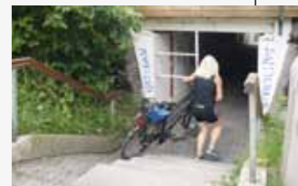
Treppe und zu steil geneigte Rampe am Zugang zur Unterführung, Querunginsel im Bereich des Durchgangs zum See schränkt durch unebenes Pflaster Barrierefreiheit ein
