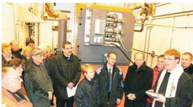
Mit Wasser aus Lourdes weihte Pfarrer Holger Fiedler die neue HackschnitzelAnlage, die künftig nicht nur kommunale Häuser mit Wärme versorgen soll. F.: nr
