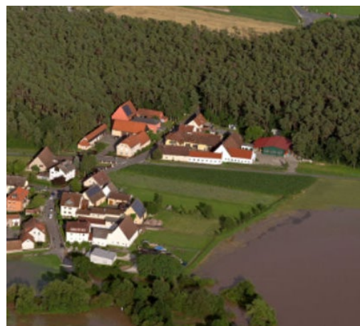
Hochwasser Aisch Juli 2021 Luftbildaufnahme Nainsdorf (BayernAtlas, Historische Hochwasserereignisse)
