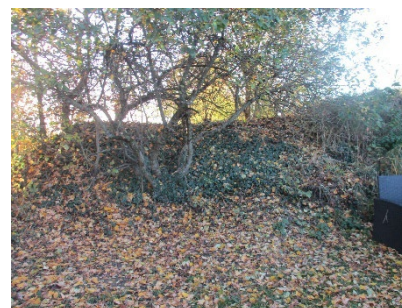
Böschung am Flurweg (Gartenseite)
